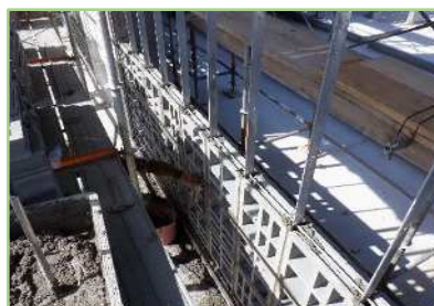
開口部 (W : 5.6m × H : 3.2m) 鉄筋背筋
